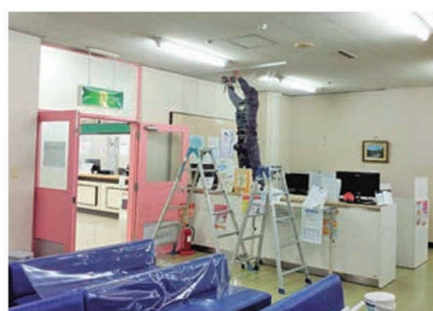
早い段階で飛沫感染を防ぐための ビニールシートを設置
