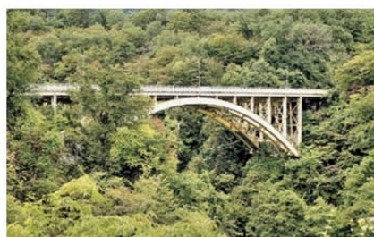
鳴子峡レストハウス側から大深沢橋を望む
